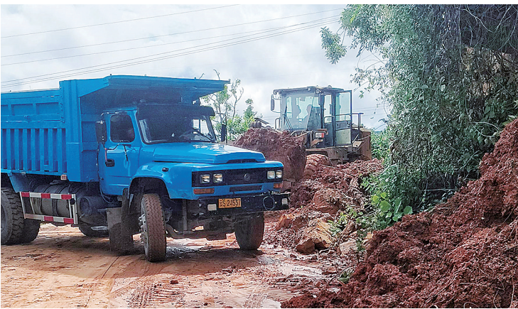
图为抢险保通现场。
