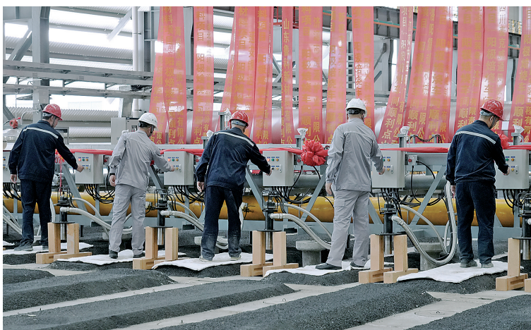
图为项目点火现场。
