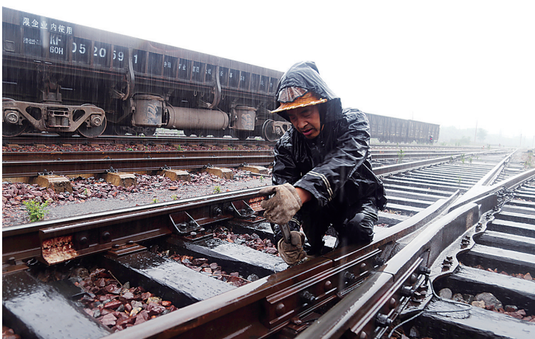
图为中铝物流中部陆港员工冒雨紧固钢轨接头螺栓。 欧阳建设 摄
