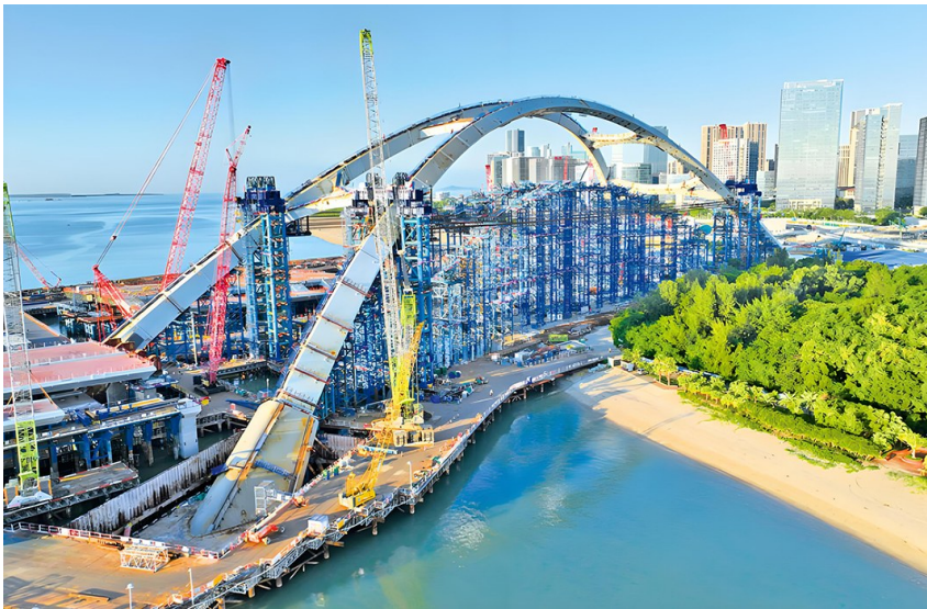
图为厦金大桥(厦门段)项目观音山互通主线桥。
