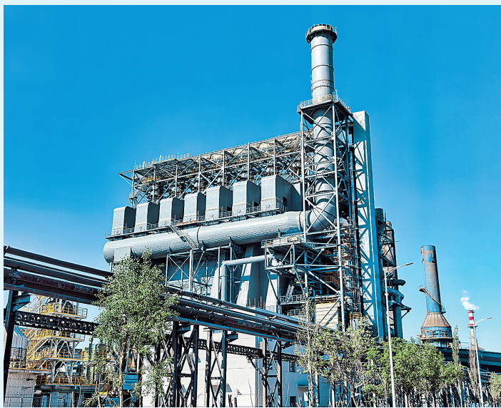
图为六冶承建的新疆某公司烧结脱硫脱硝改造项目。冯康 摄
