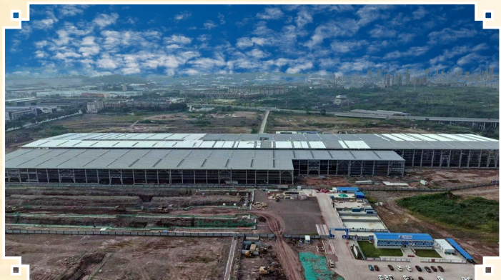
图为项目建设现场。 晁慧民 摄
