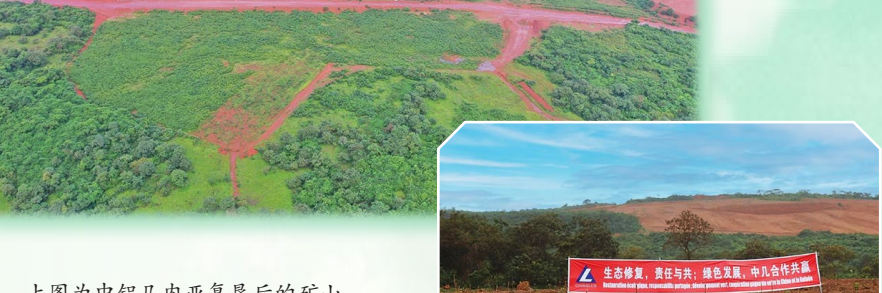
右图为中铝几内亚复垦项目开工。
