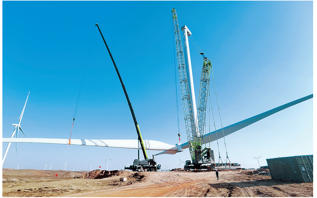
▲图为银星能源长山头风电场“以大代小”技术改造项目现场。 曹维斌 摄
