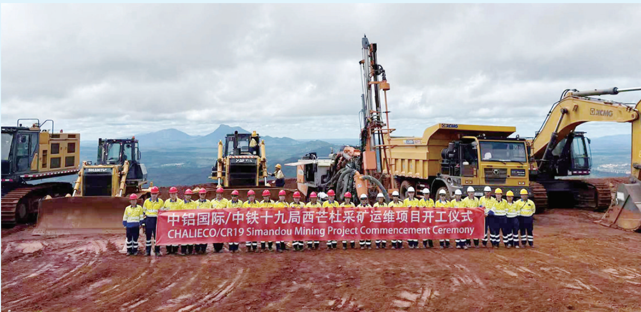
▲图为项目开工仪式现场。
