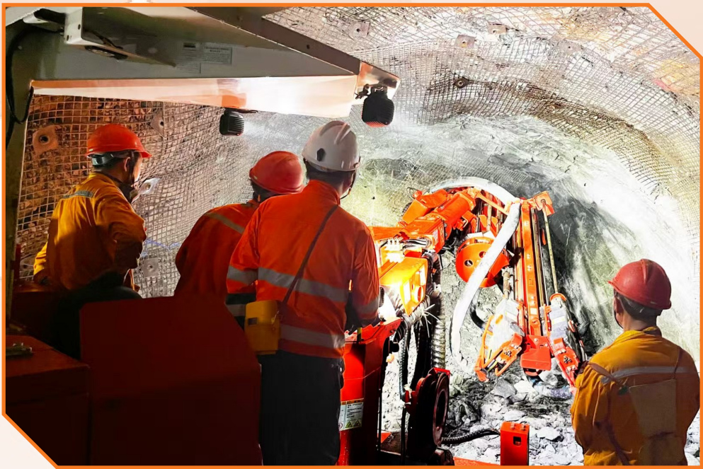
图为会泽矿业井下作业现场。
