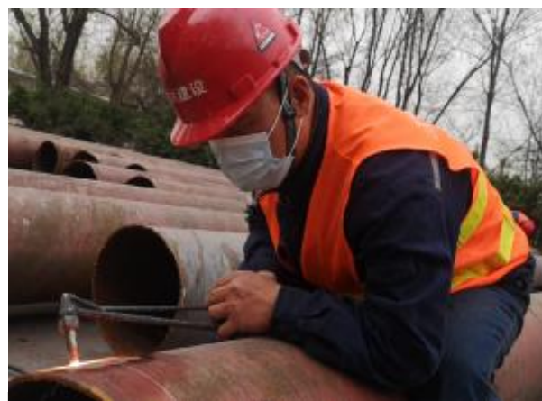
近日,冶炼设备技术分公司第一项目部承揽了阳光焦化集团生活区燃气管线技改工程。此项工程需要制作安装钢结构及管道支(吊)架150个,燃气管线1730米,计划工期40天,预计创效55万元。目前,各种管道制作正紧张施工中。图为员工正在焊接管道。 摄影报道 柴春生
